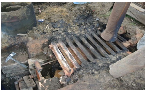
Рис. 7 Укладка газогенераторной печи
